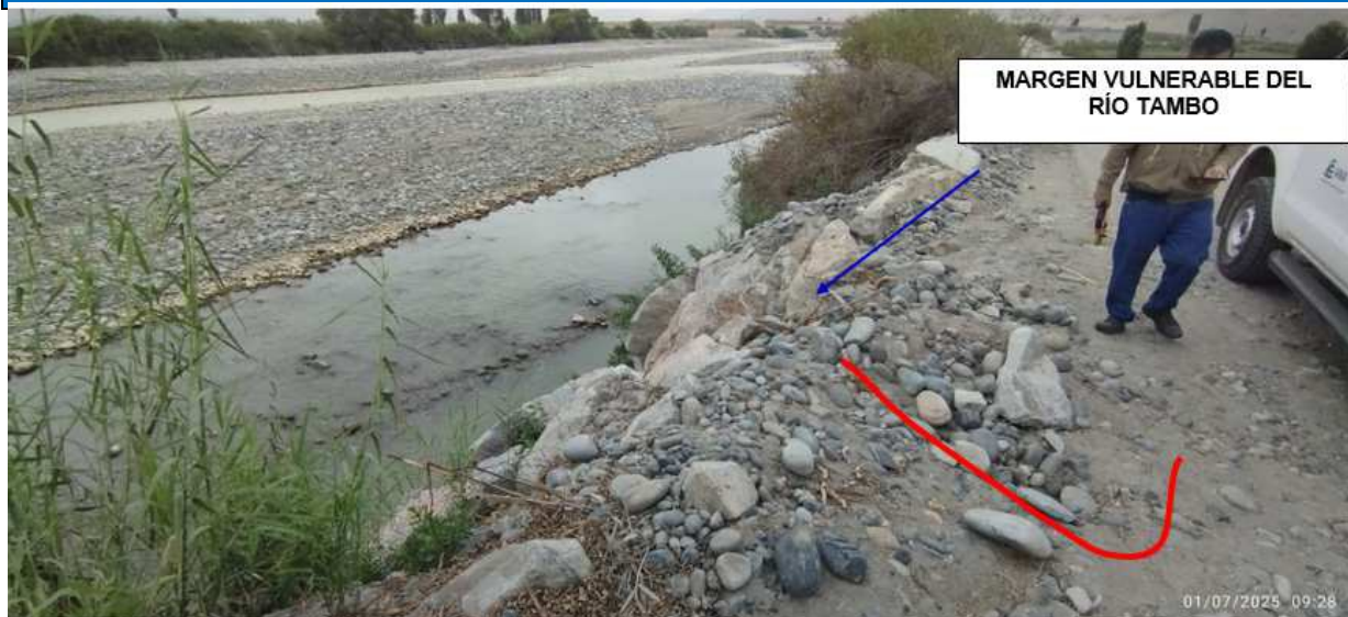
FIGURA N°01: TRAMO 01 INICIO DE ACTIVIDADES, TRAMO DE DIQUE CON ENROCADO DE PROTECCION CAIDO HACIA CAUCE INICIA AGUAS ABAJO DE PUENTE FREYRE MARGEN IZQUIERDA DE RIO TAMBO
