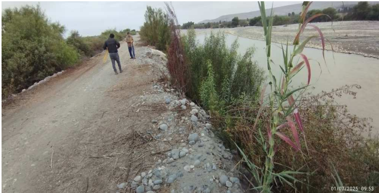
FIGURA N°02: TRAMO CRITICO 054, , PERDIDA DE ENROCADO DE PROTECCION EN TALUD DE DIQUE, RALA VEGETACION CONTENDENCIA A EROSION DE DIQUE DE MATERIAL PROPIO DE RIO
